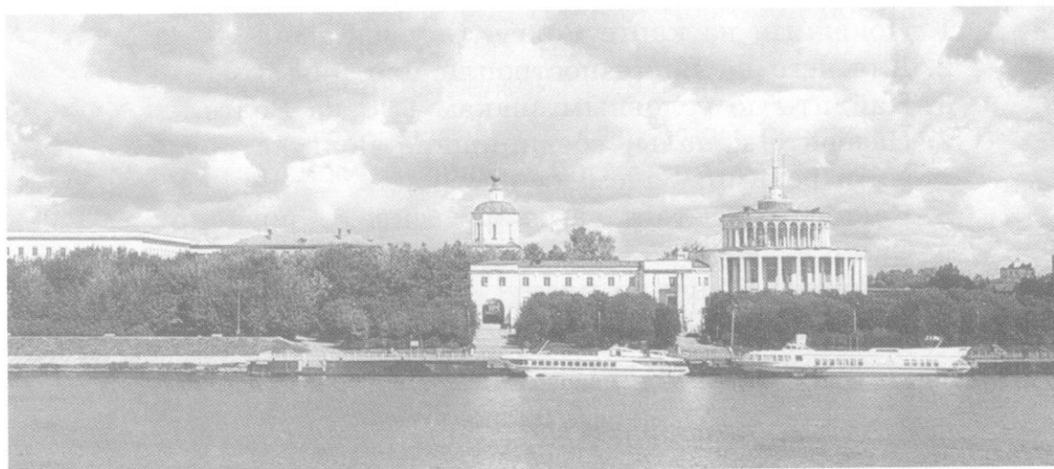
Рис. 139. Город Тверь на Волге. Здание речного вокзала
